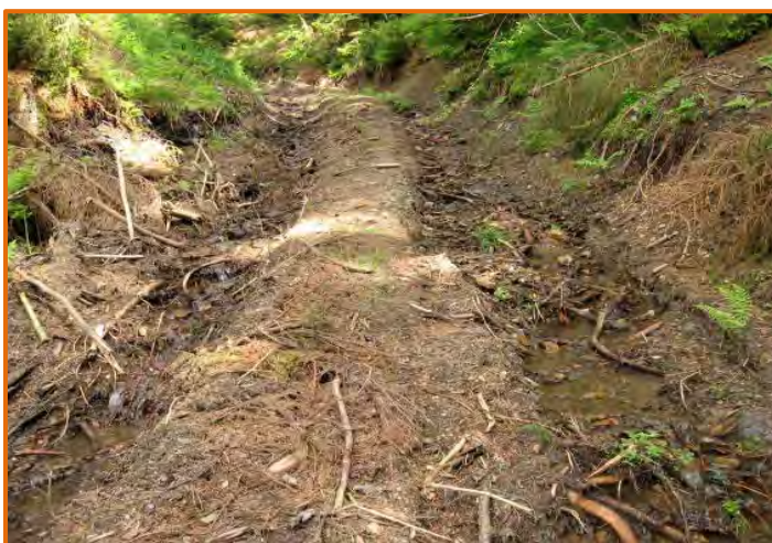
Abbildung 4.8 Waldschäden infolge Einsatzes schwerer Forstmaschinen (Quelle: AfL 2013).
