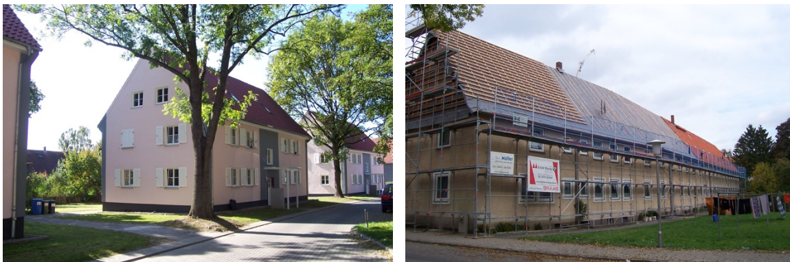
Fotos 4: Denkmalgerechte Modernisierung Helenenstraße sowie Dachsanierung Okerstraße
